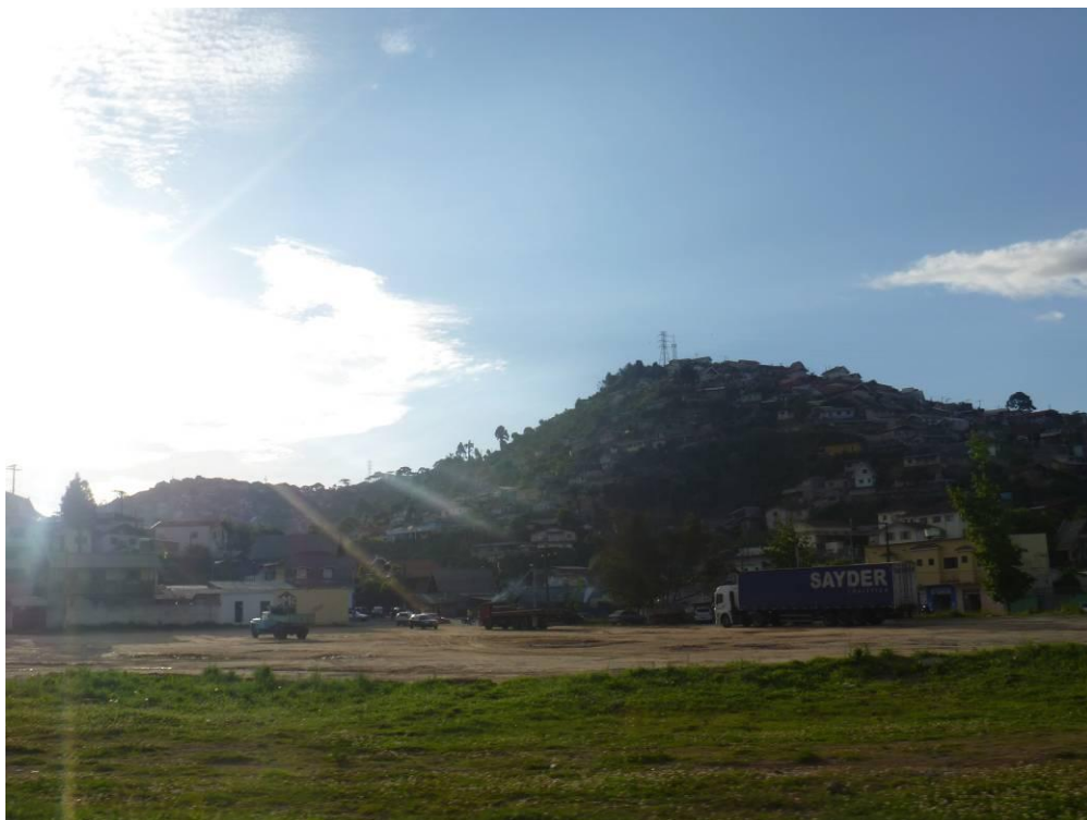
Ocupações em Área de Risco Próxima ao Pórtico de Entrada de Campos do Jordão
