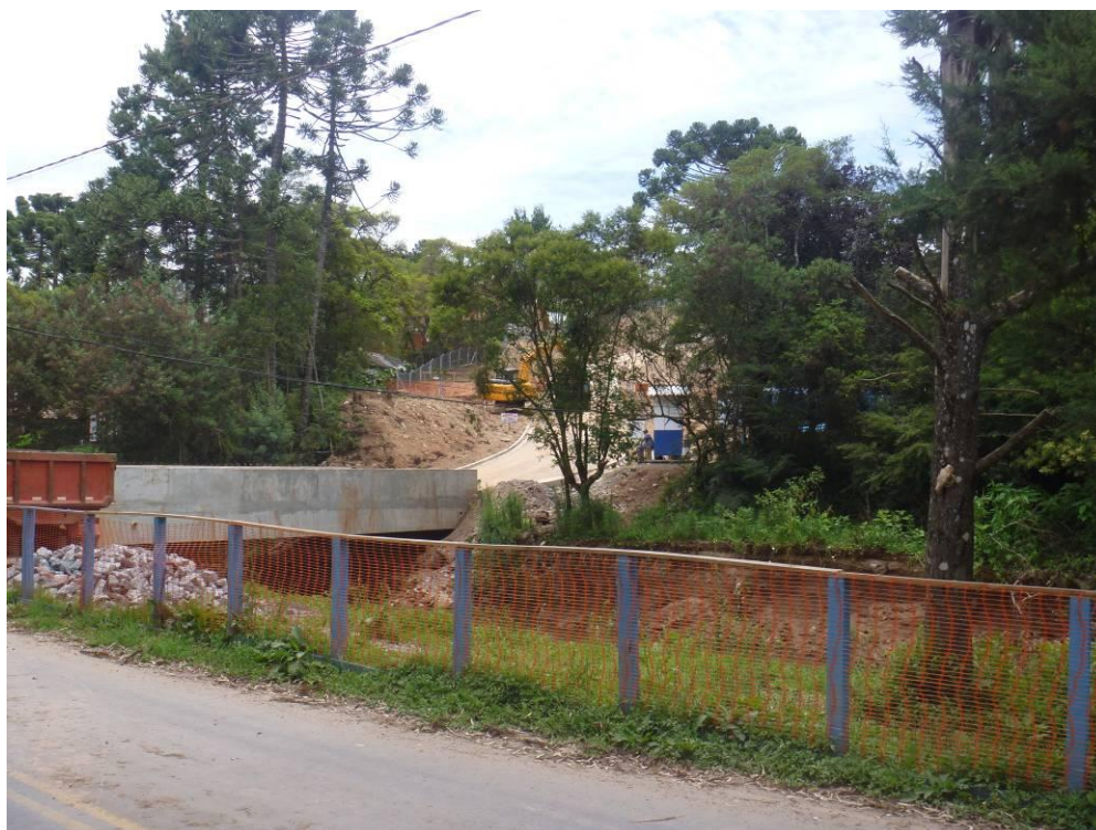
Obras da Futura ETE – Av. Pedro Paulo
