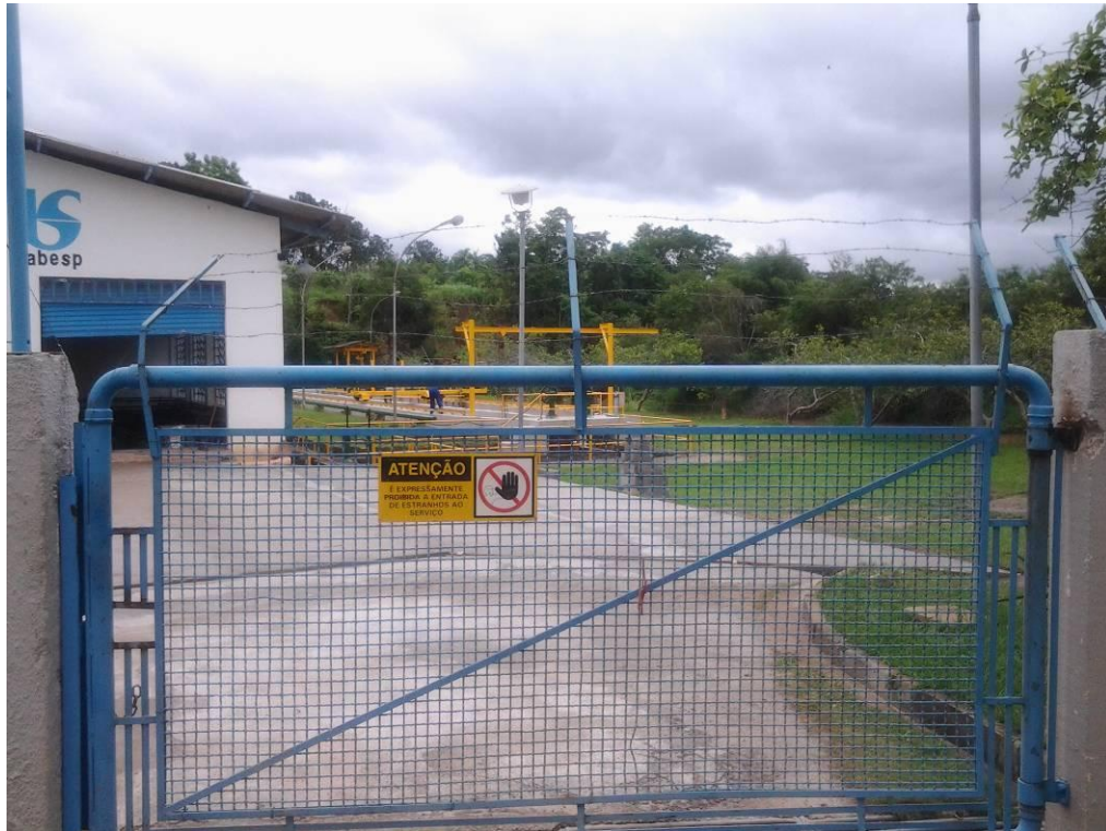
Estação do Tratamento de Água (Estrada do Ipiranga)
