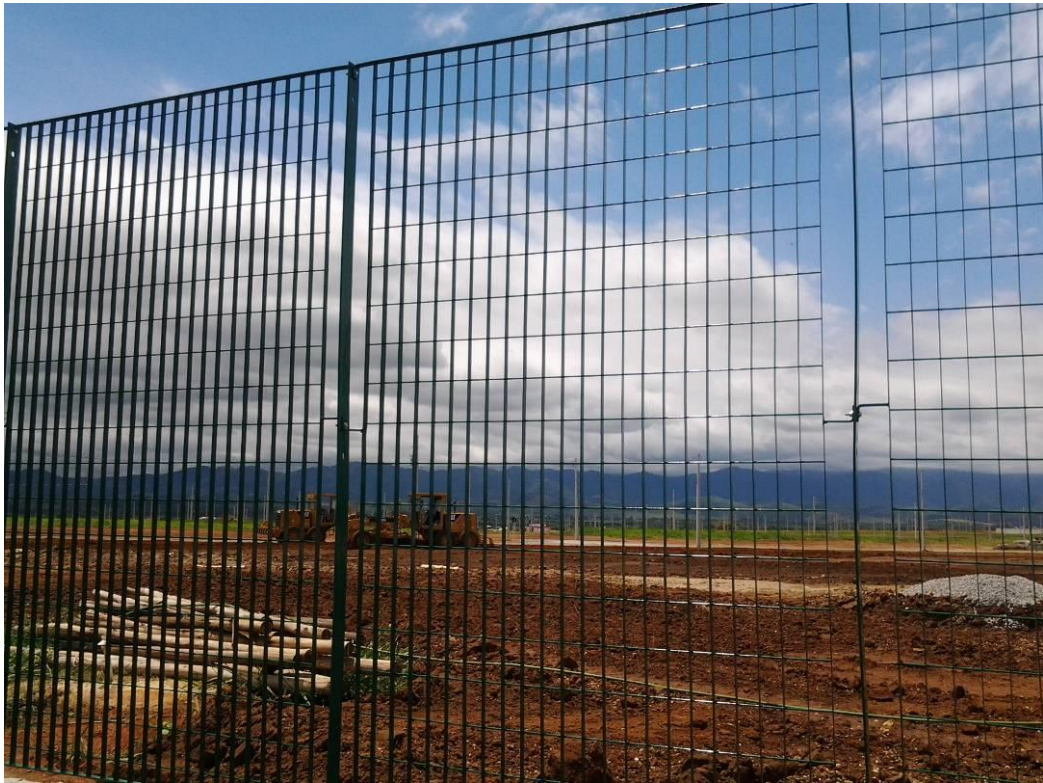
Loteamento em construção (Distrito Quiririm)
