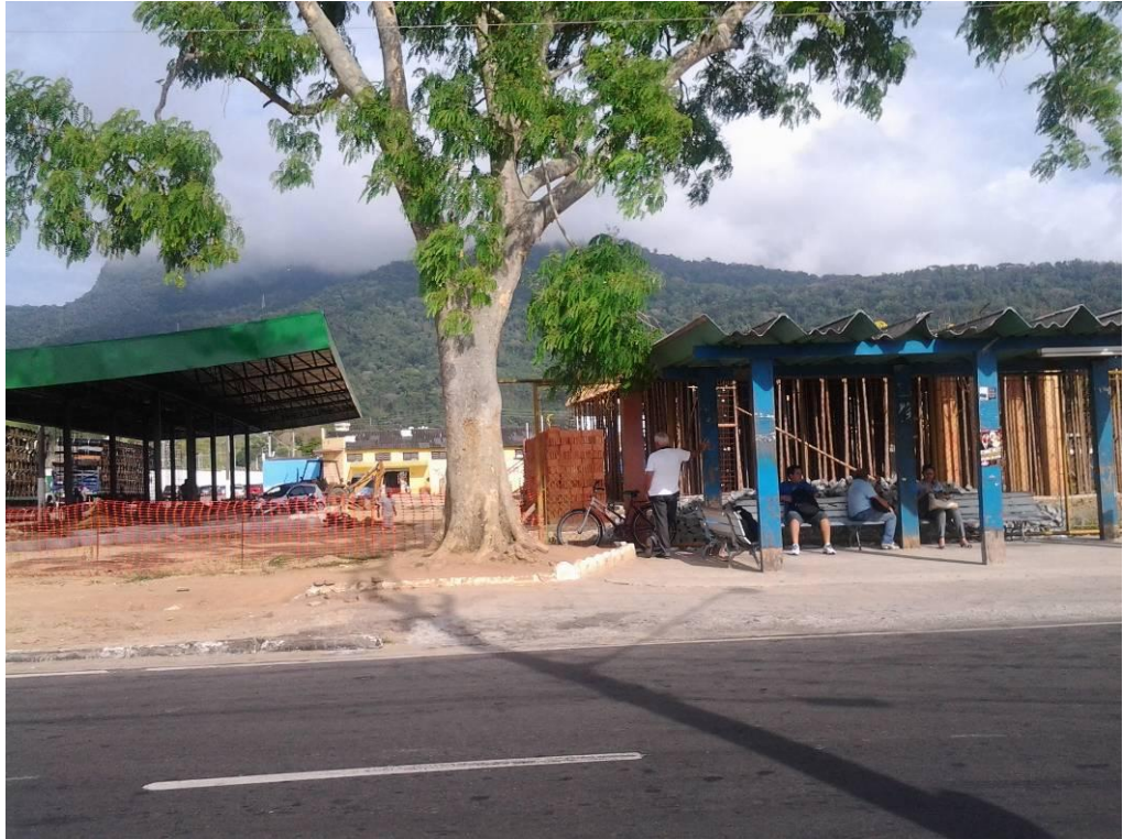
Construção da futura Rodoviária (Rua São Geraldo)
