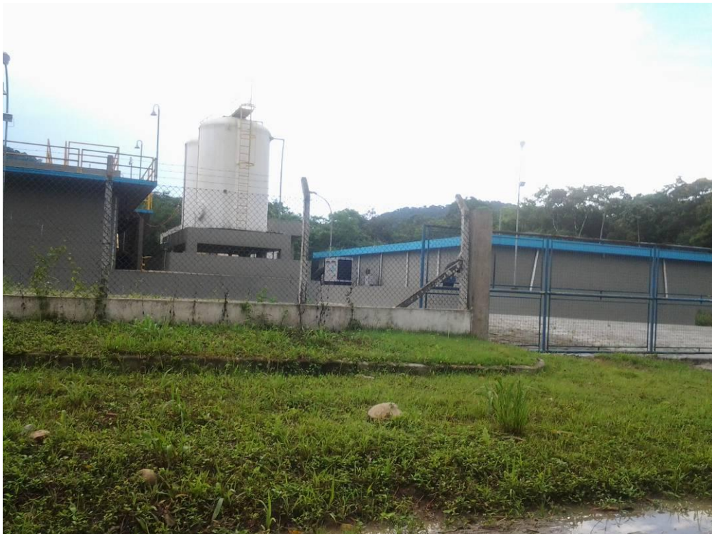
Estação de Tratamento de Água (Parque Estadual da Serra do Mar)
