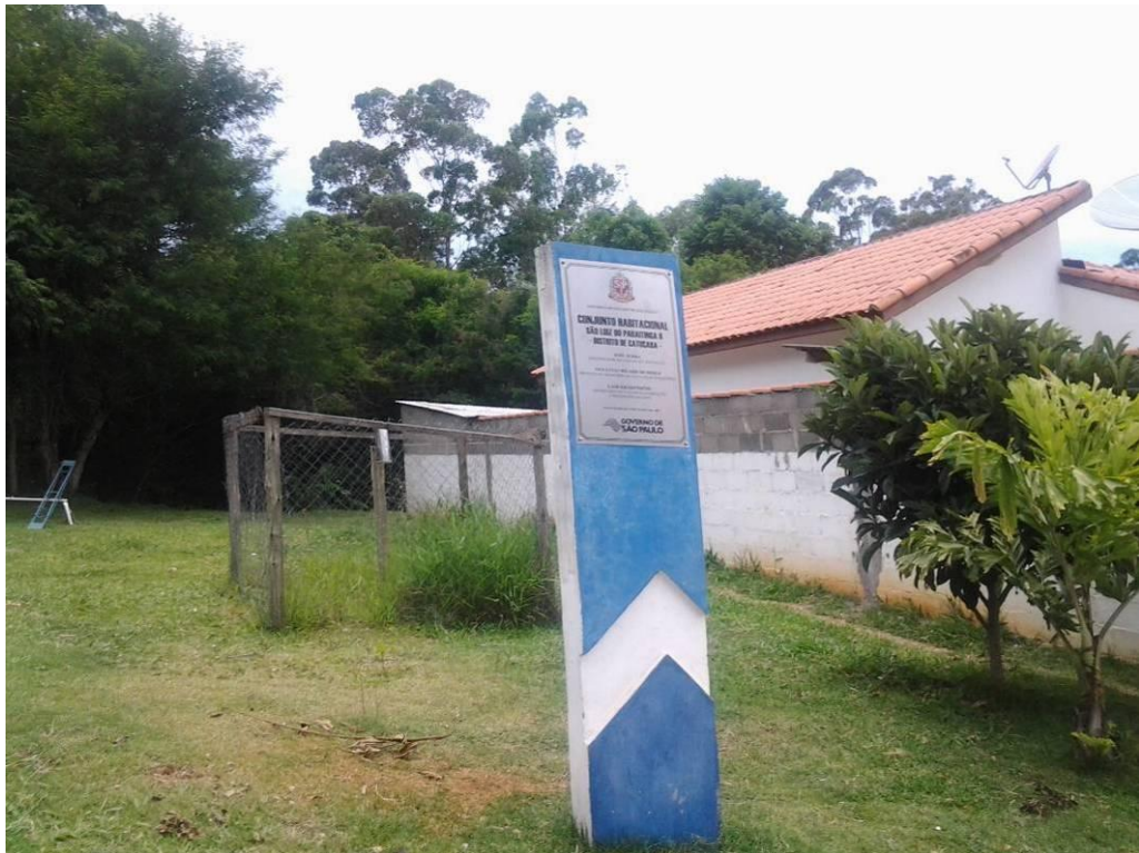
Conjunto habitacional (Bairro Catuçaba)
