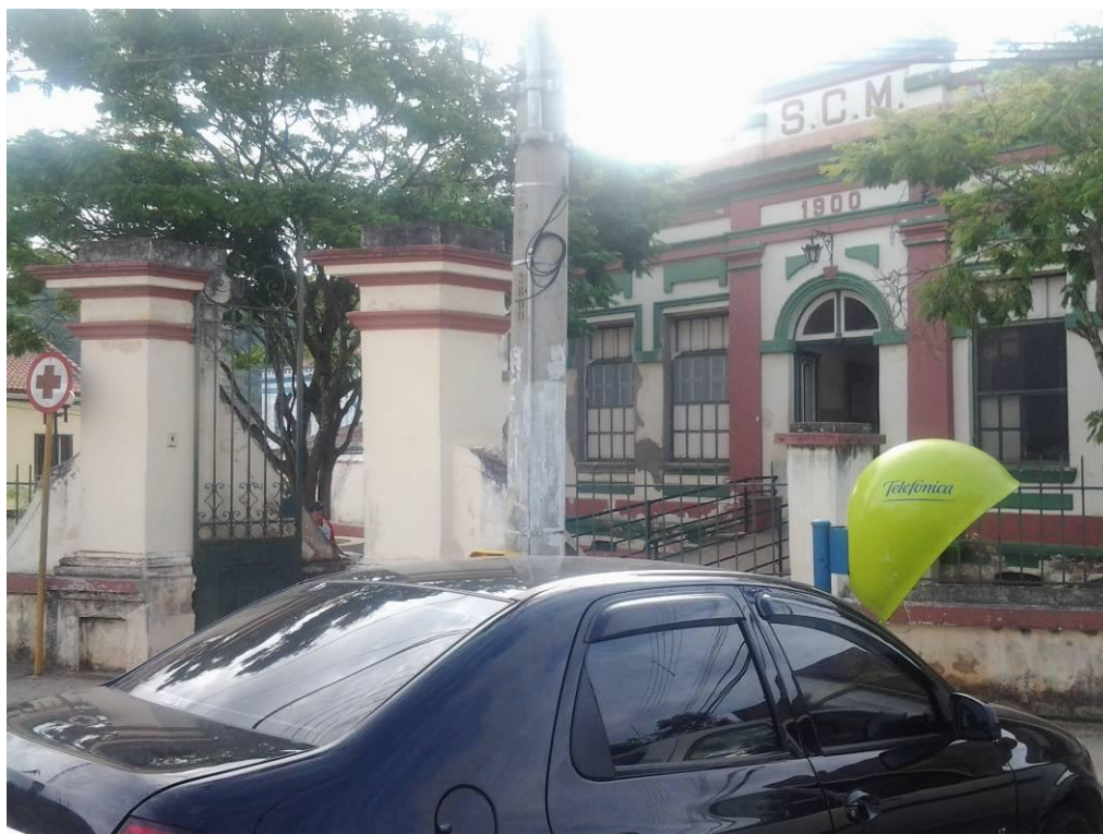
Hospital municipal (Centro Histórico)
