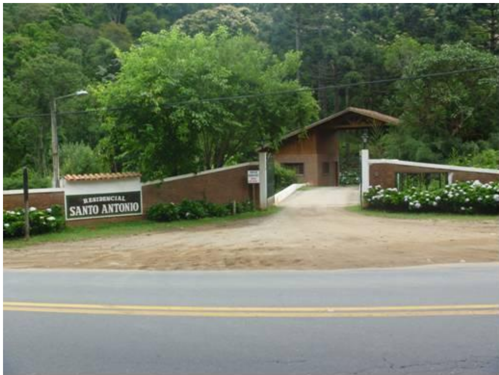
Residencial Santo Antônio / Bairro da Cachoeira – SP 046`
