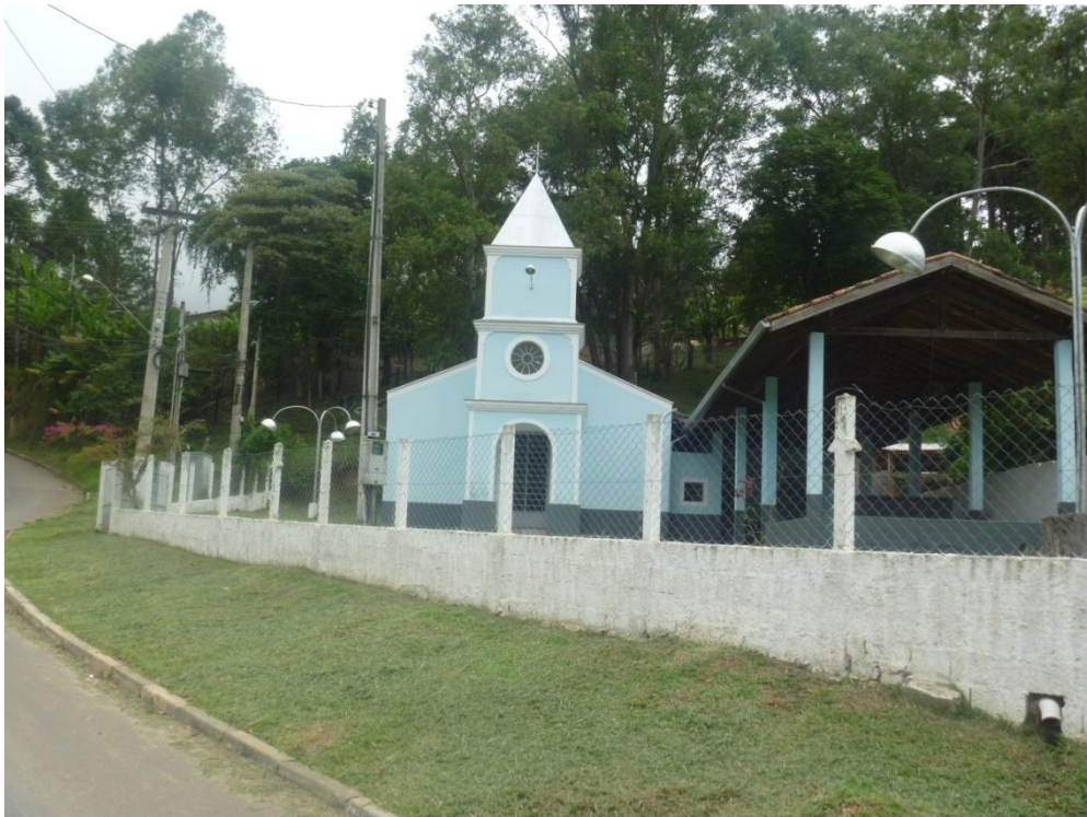
Igreja Nossa Senhora do Perpétuo Socorro / Bairro Lajeado – STP 343
