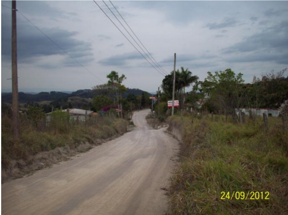
Estrada de Saibro – Bairro Estância Nova Campos do Jordão
