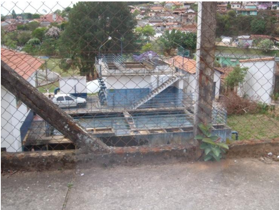
Estação de tratamento de água
