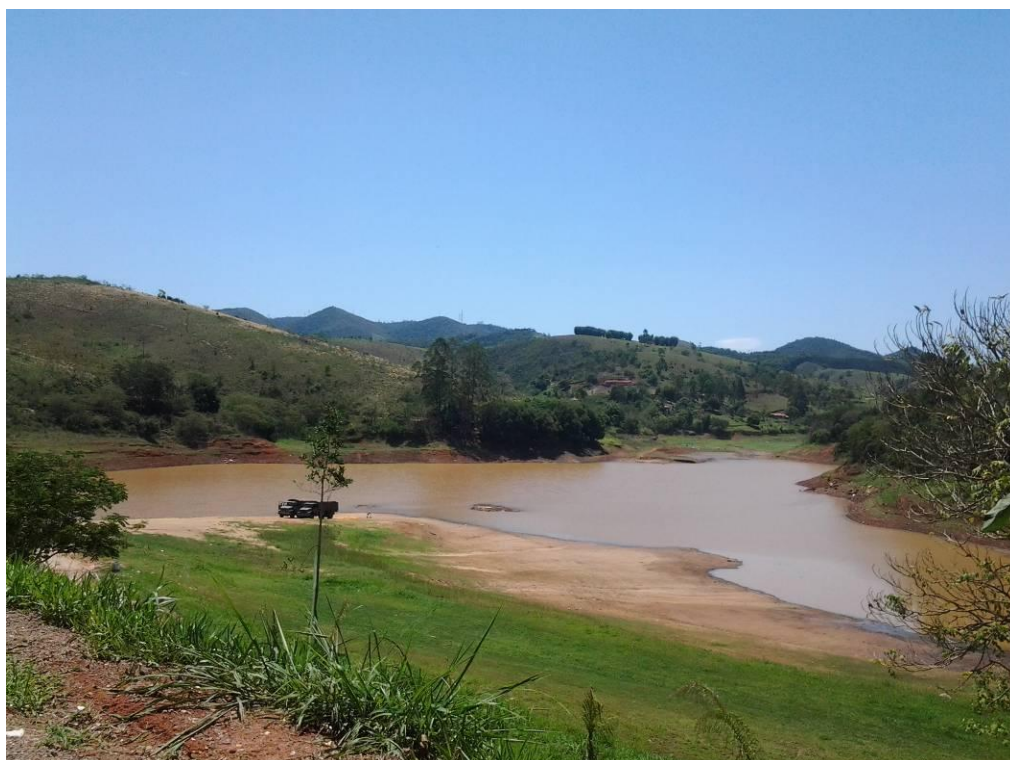
Reservatório com baixo nível de água
