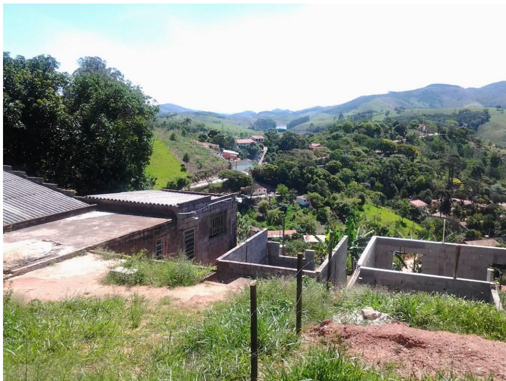
Morro ocupado, domicílios em construção na declividade do Terreno
