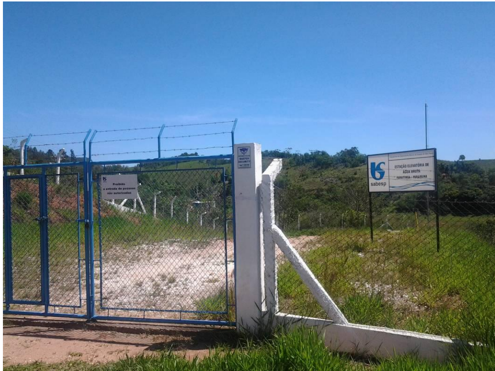
Estação elevatória de água bruta - Sabesp
