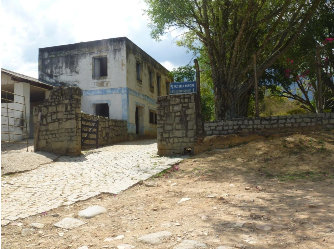
Entrada da Fazenda Bela Aurora UIT Fazenda da Restauração
