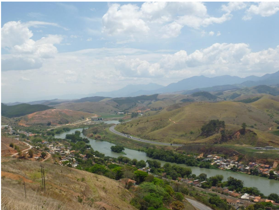
Ao fundo Importante Equipamento de Infraestrutura Hidrelétrica (responsável pela energia que abastece o município)
