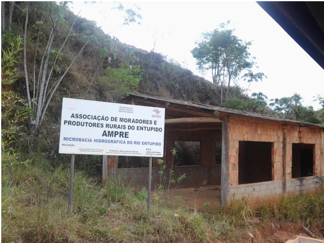
Sede em construção da Associação dos Moradores Bairro do Entupido
