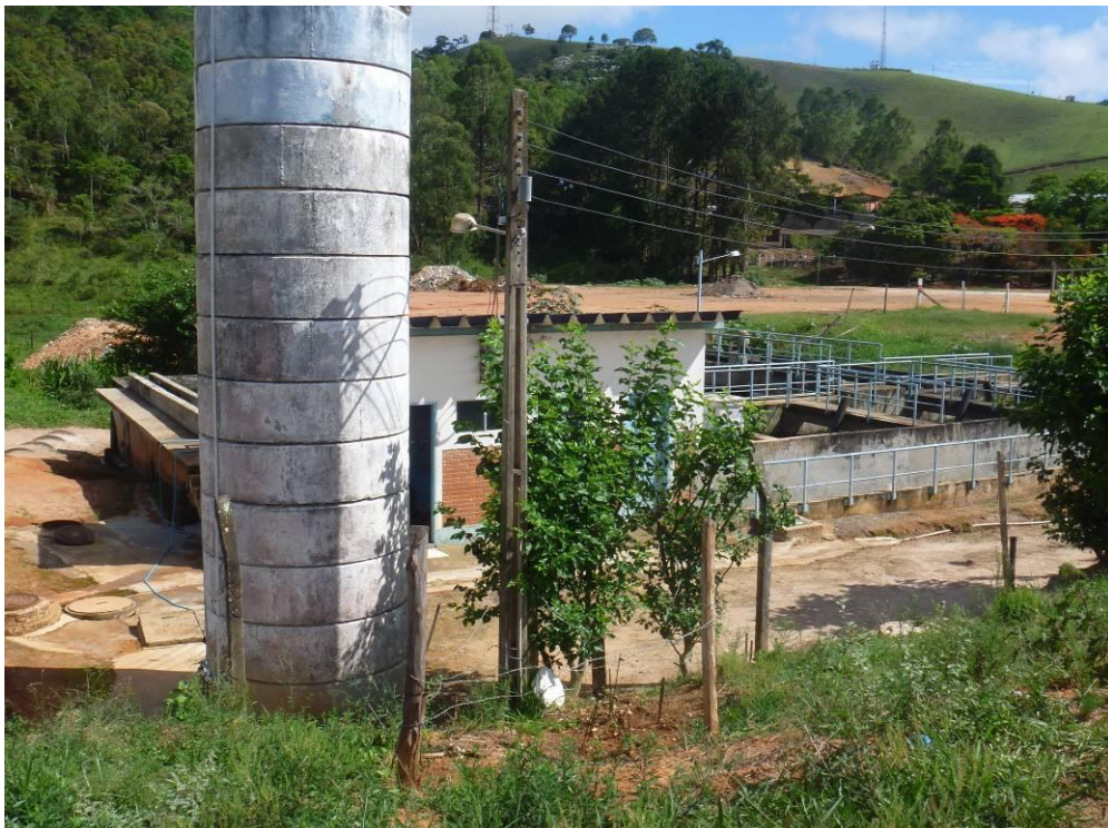
Estação de Tratamento de Água (Centro)
