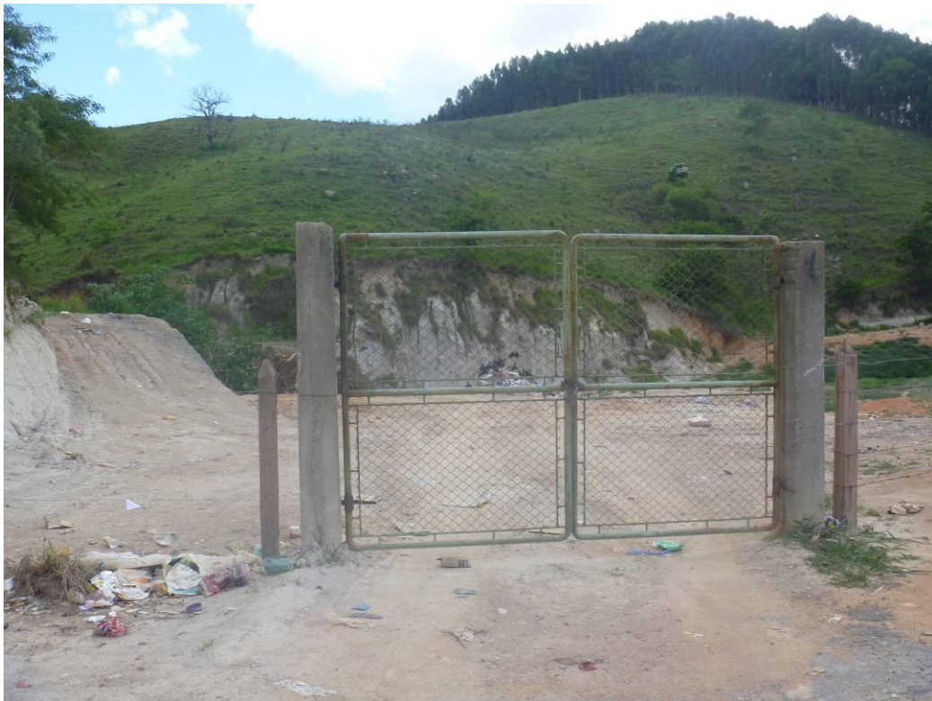
Aterro sanitário municipal
