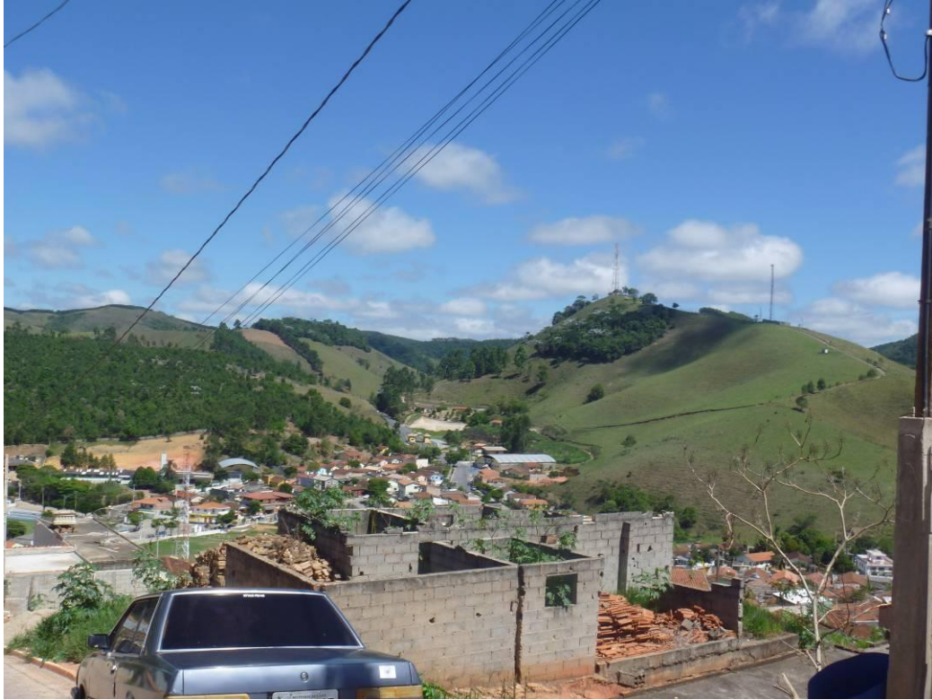
Residencial em construção (Rua Eliseu Pinhal)
