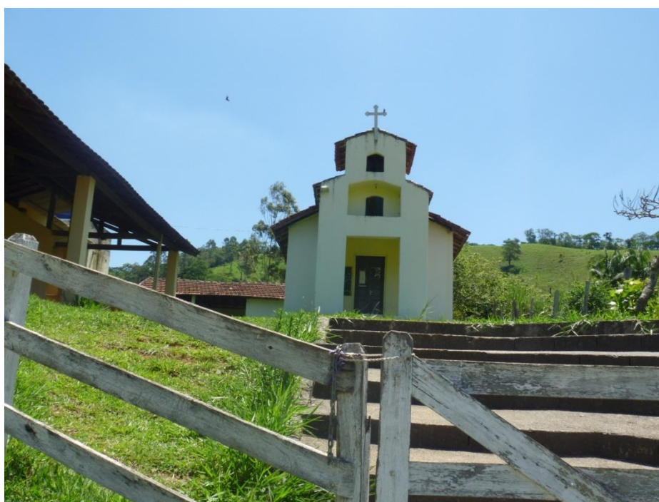
Bairro Pedra Branca / Estrada Municipal Pedra Branca Igreja de Santo Antônio
