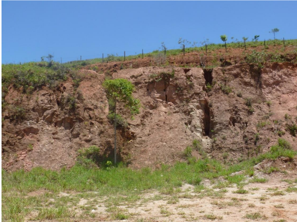
Bairro Pedra Branca / Estrada Municipal Pedra Branca: Solo exposto
