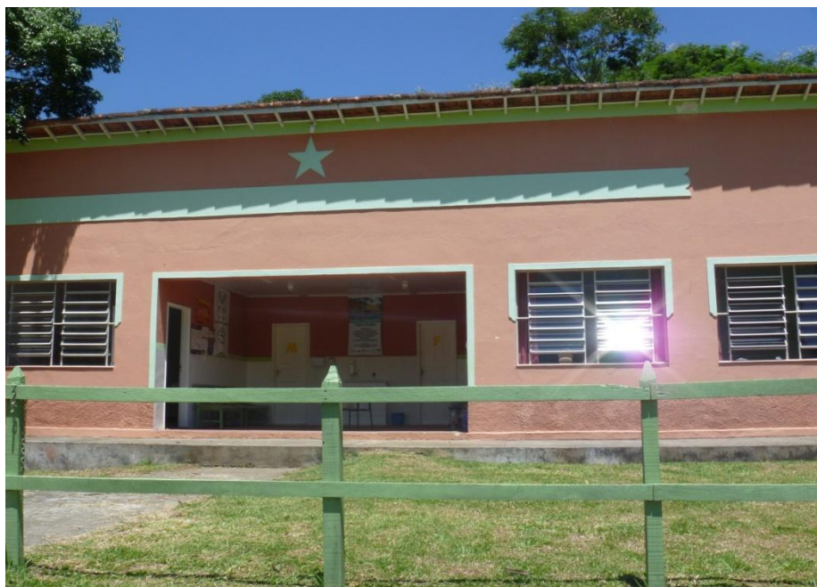
Bairro Pedra Branca / Estrada Municipal Pedra Branca Centro Comunitário Pedra Branca
