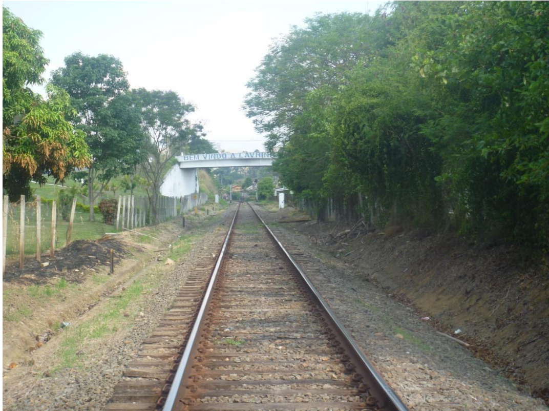
Linha Férrea – Transporte de Bobinas de Aço Vindas de Volta Redonda
