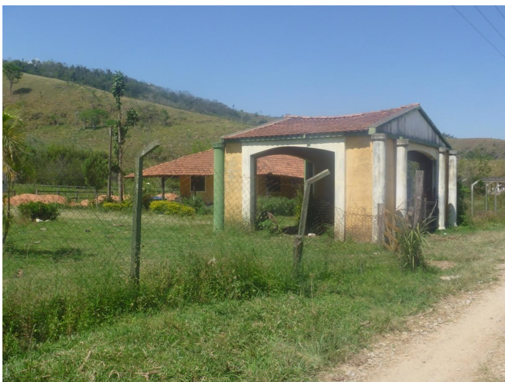
Área Destinada à Captação e Envasamento de Água Mineral Divisa com Queluz
