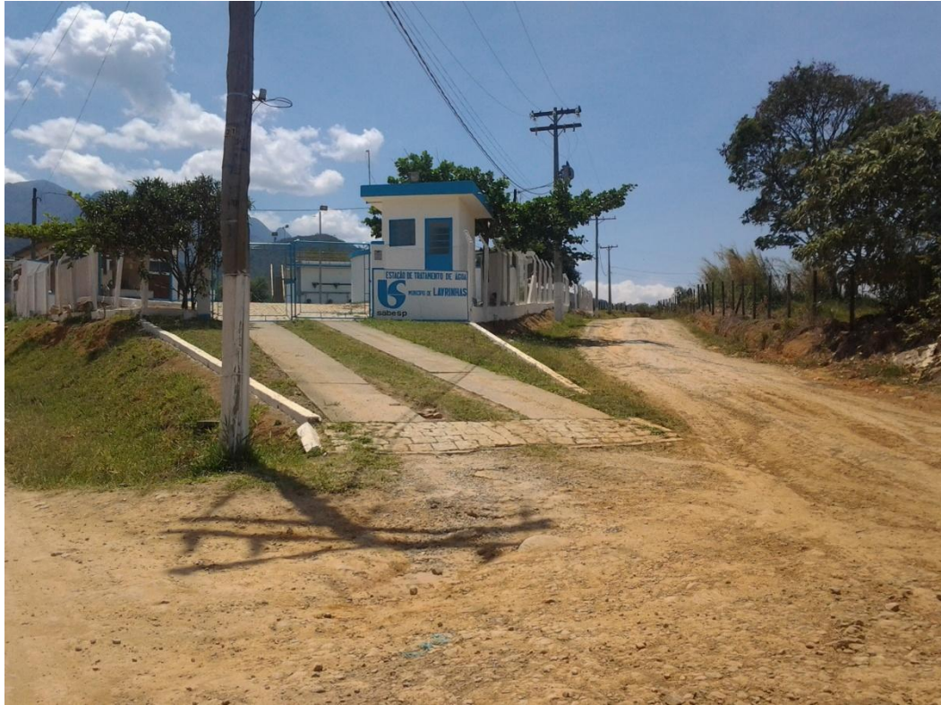
Estação de Tratamento de Água – Av. Vô Baia
