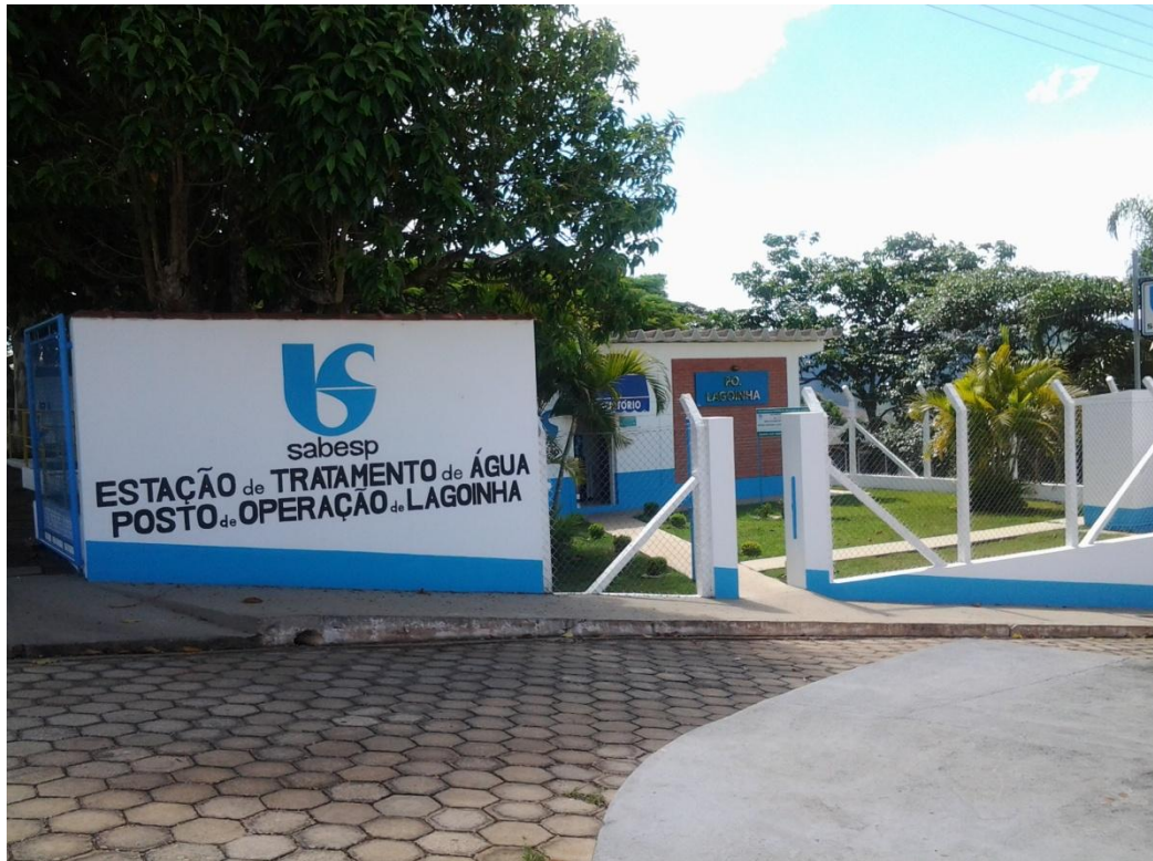
Estação de Tratamento de Água (Rua do Cruzeiro)
