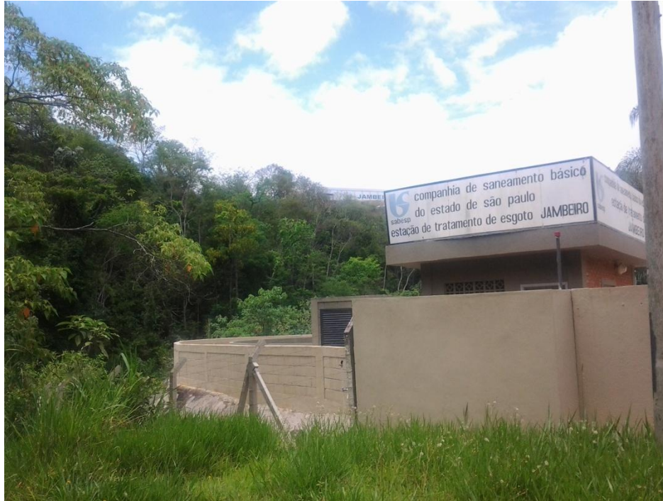
Estação de Tratamento de Esgoto Estrada Municipal JAM 341
