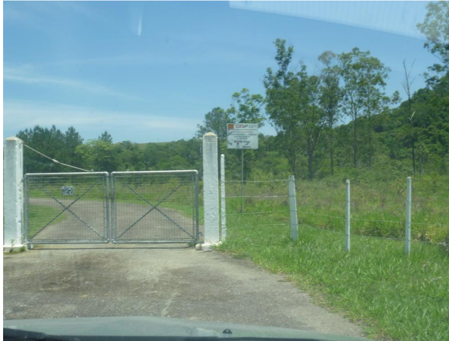
Portão de Entrada da CESP – Represa do Jaguari
