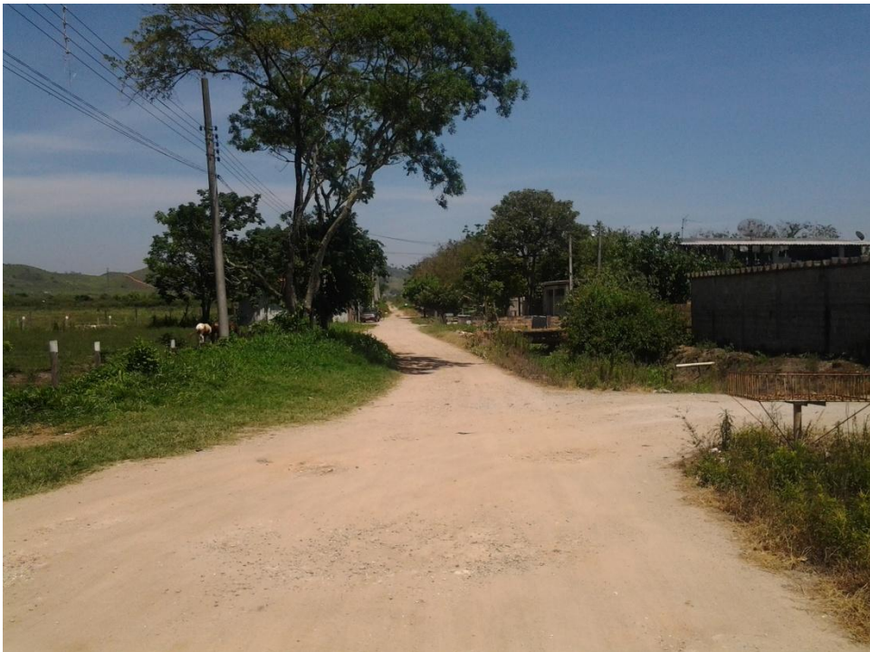
Registro da futura ligação leste-oeste, região sofre com especulação imobiliária
