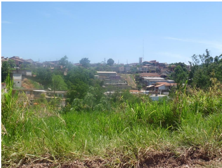
Padrão Construtivo do Aglomerado 23 de Abril Vistada a Partir da Rodovia D. Pedro I
