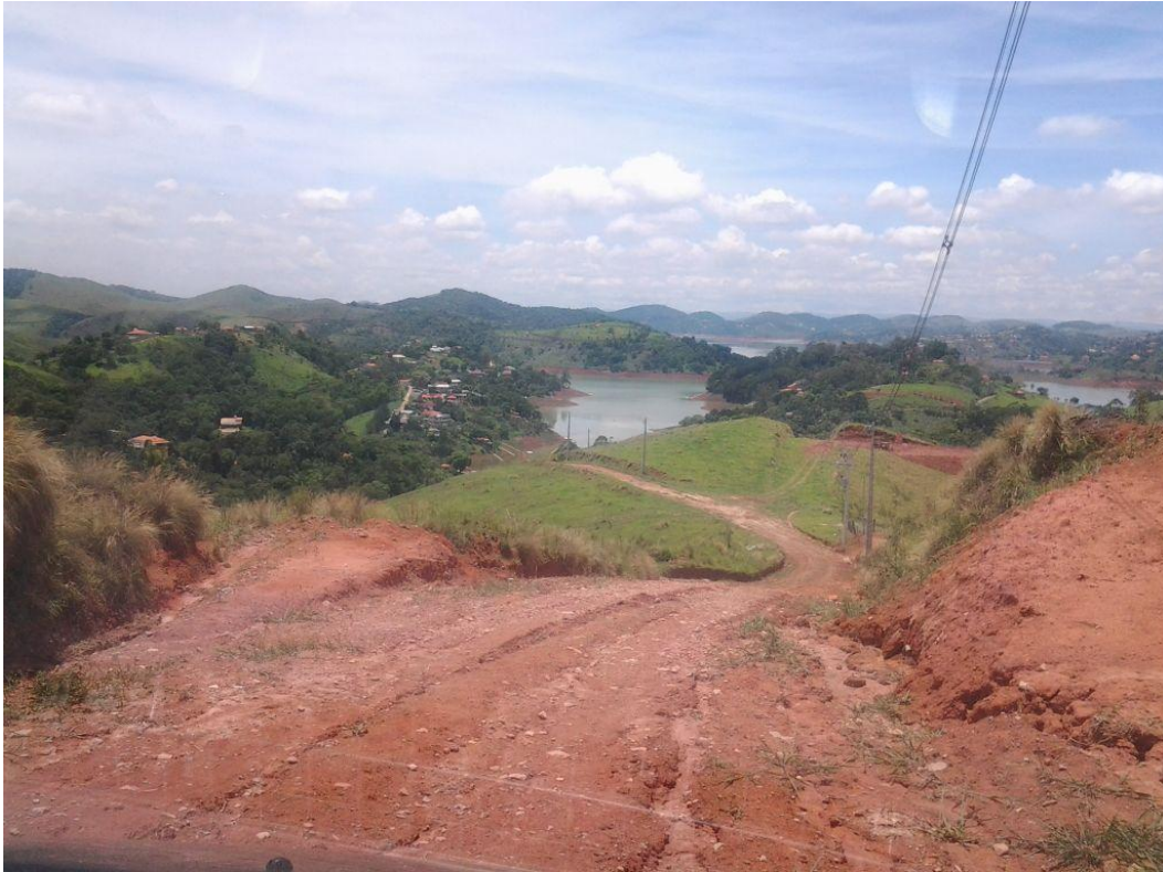
Vistada geral da UIT 2 (estrada em piores condições)
