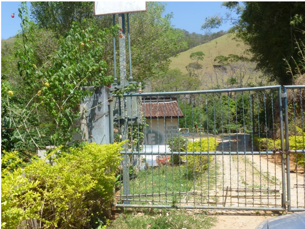
Fazenda Batedor - Captação de Água
