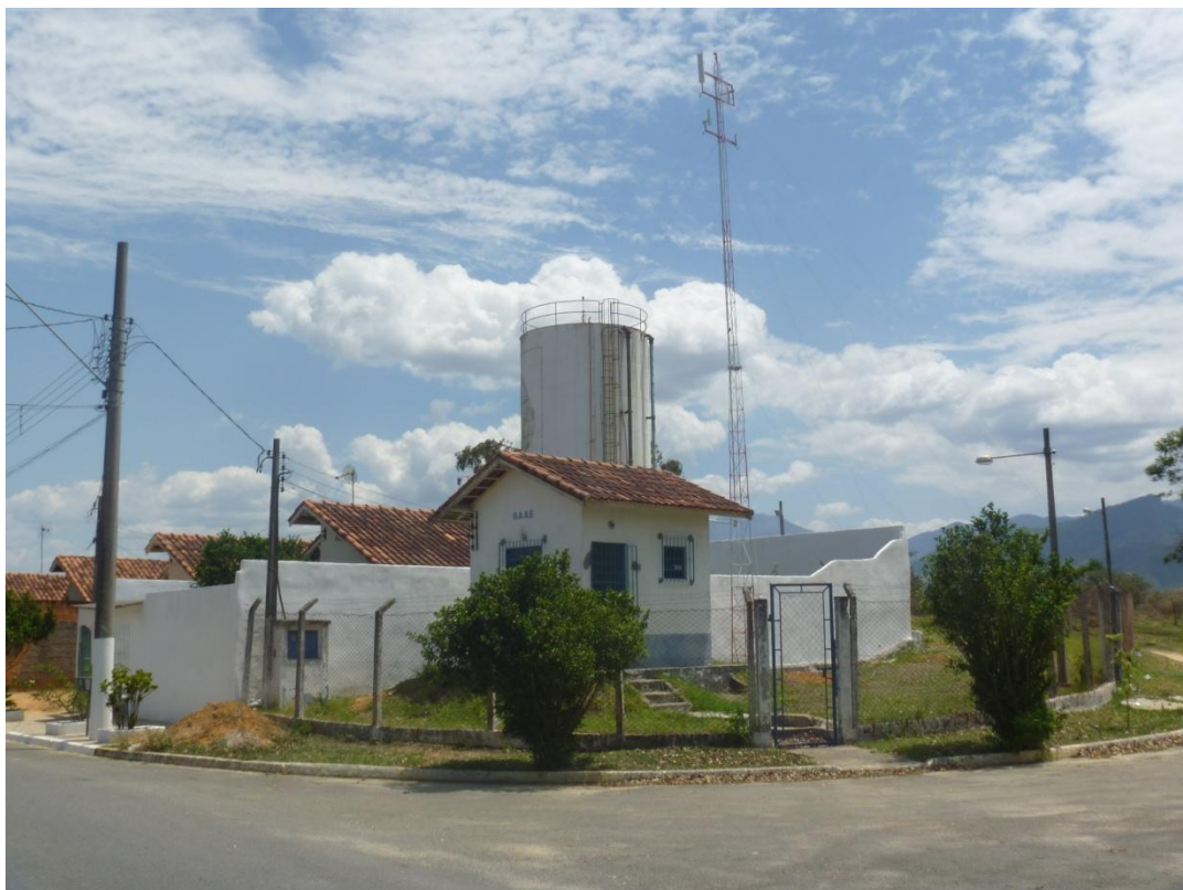
Caixa D'água da SAAE no Bairro Pontilhão
