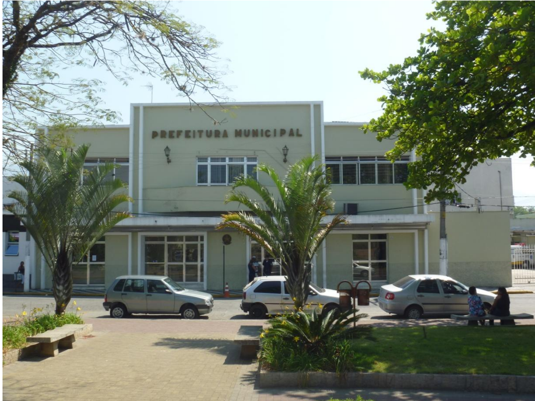
Frente da Prefeitura Municipal de Cruzeiro (Rua Capitão Neco, 1070 - Centro)
