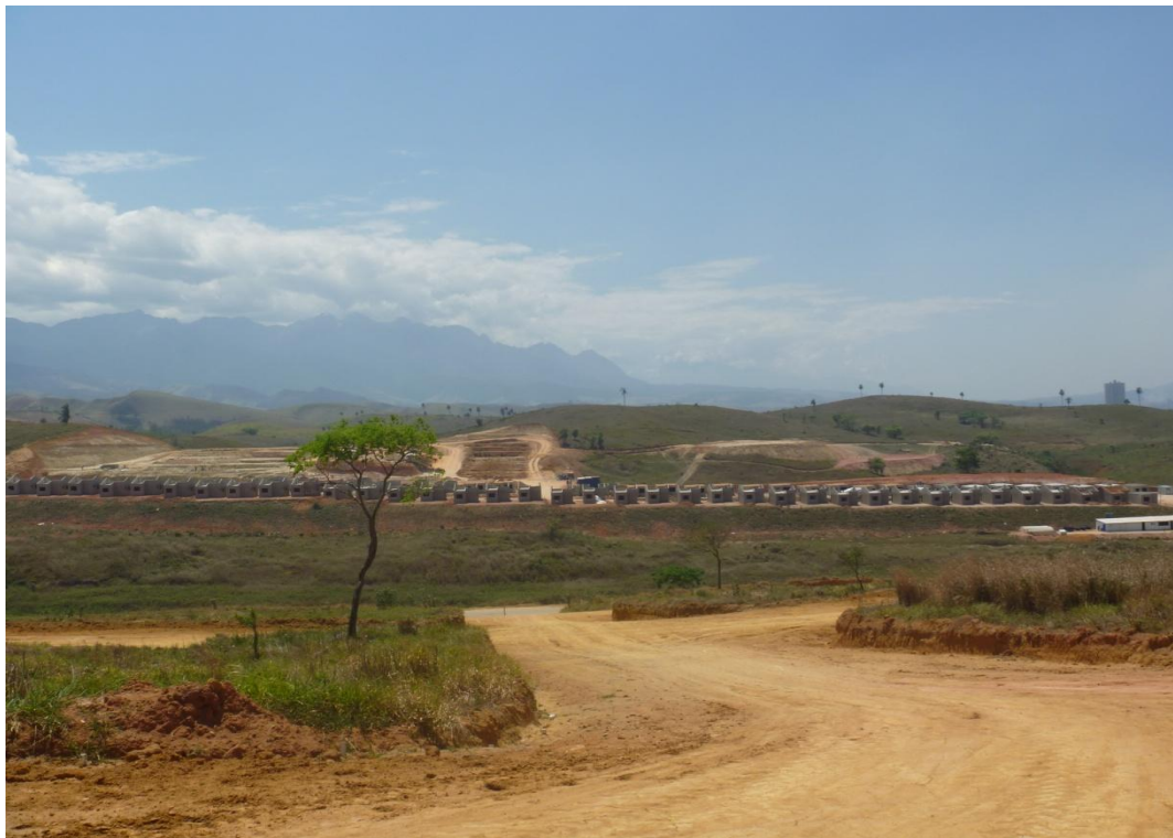
Construção do Condomínio dos Metalúrgicos – Bairro Pontilhão
