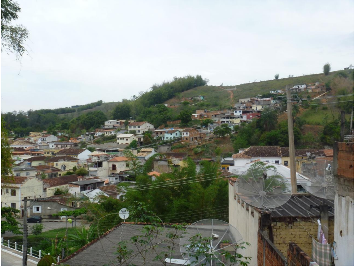
Avanço da malha urbana rumo ao morro Tentativa tímida de reter água pluvial (muro de contenção)
