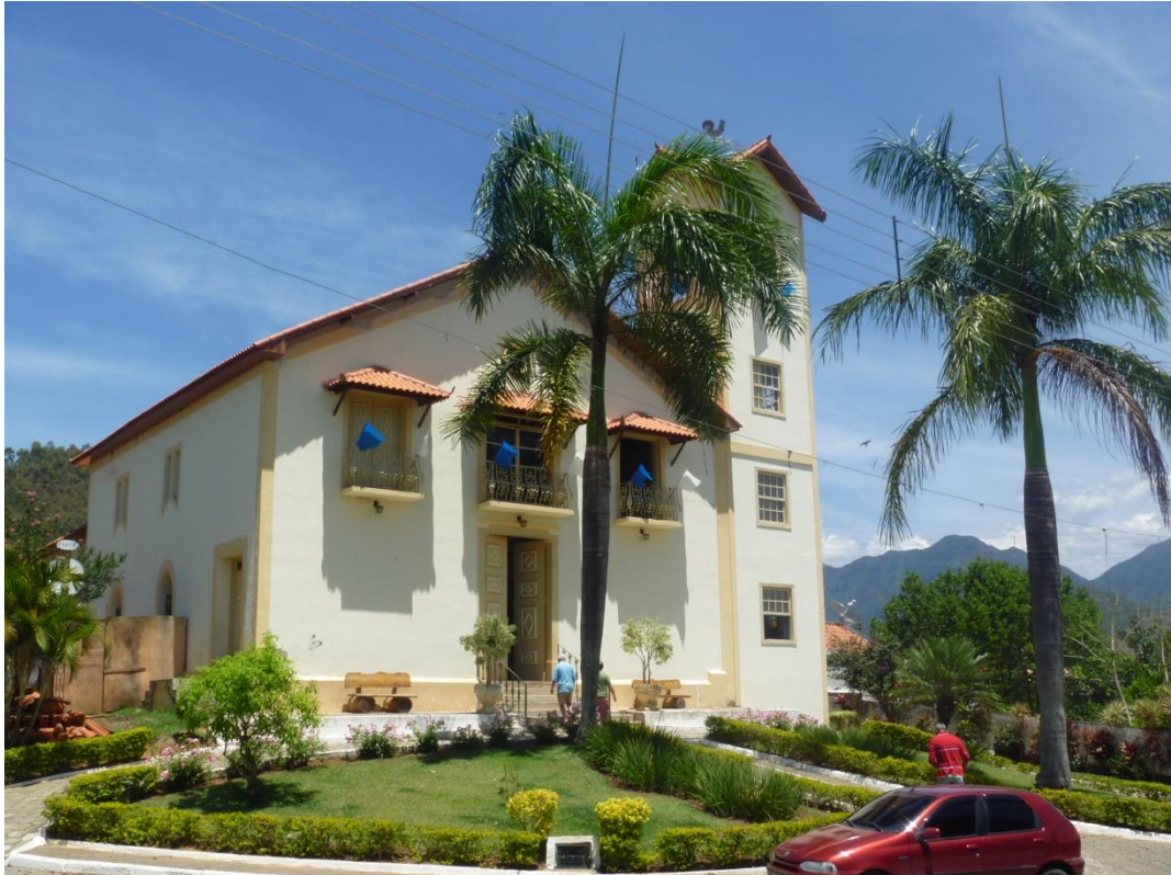
Igreja Santo Antônio Rua dos Afonsos
