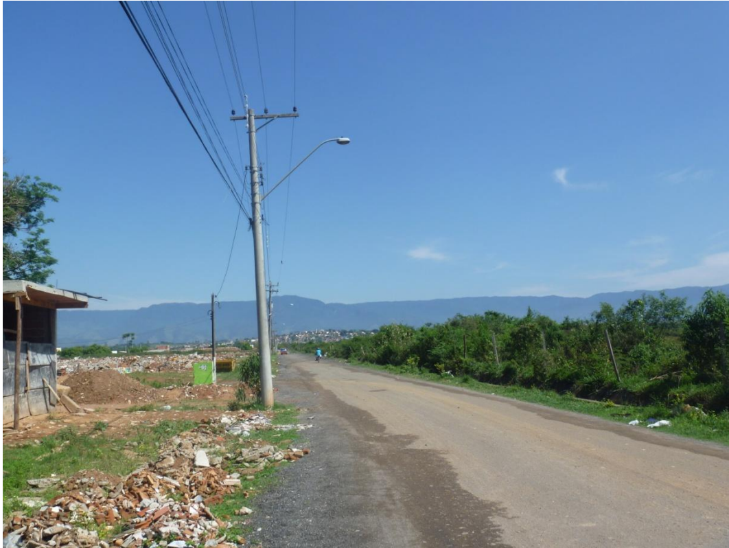
Acesso à UIT Arrozal dá sinais de degradação ambiental (continuação da Rua M. Pedro Filippo)
